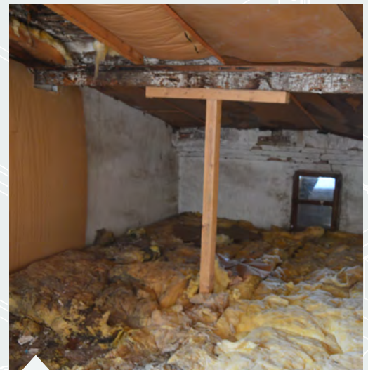
Combles de l'ancien bâtiment
